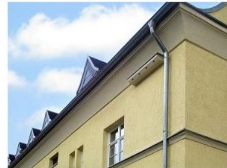
Dvoukomorová budka z extrudovaného polystyrenu
